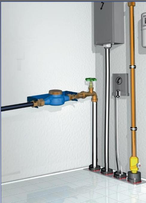
Um ein Optimum an Sicherheit zu gewährleisten, schreibt der Zweckverband Karkbrook seit Januar 2018 den dauerhaft dichten Einbau von Ein- und Mehrsparten-Hauseinführungen vor. Er schützt dadurch seine Kunden vor Gas- bzw. Wassereintritt aus dem Erdreich.
