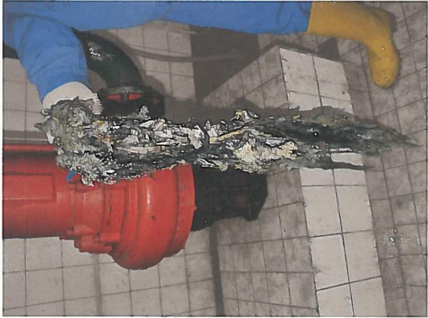
Sieht übel aus und ist es auch: verfilzte Feuchttücher. Regelmäßig legen sie Abwassersysteme lahm.
